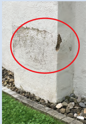
Wasserschaden Kamin und Folgeschaden im Keller
