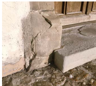
Natursteingewände der Eingangstüre und Sockel
