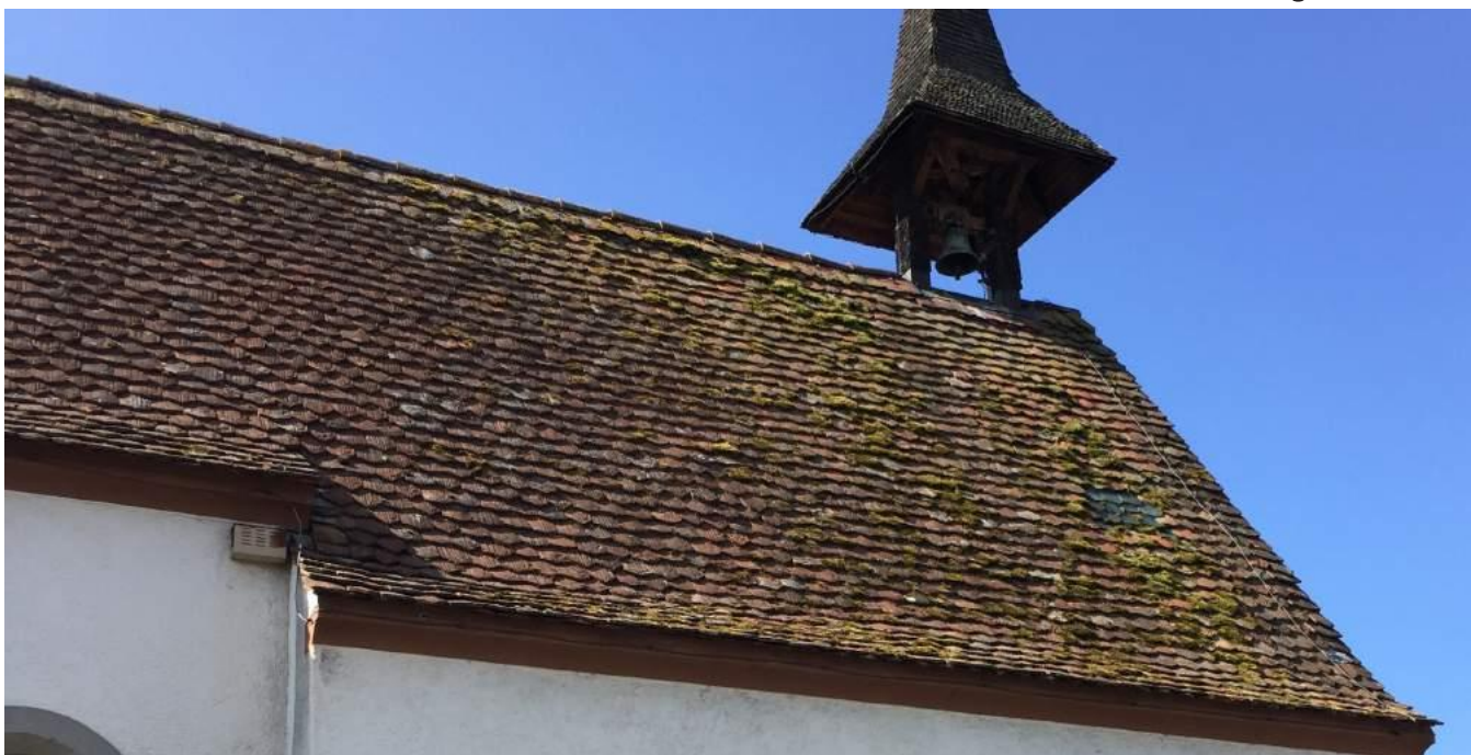
Oktober 2018 Dach, Blick nach SW:
