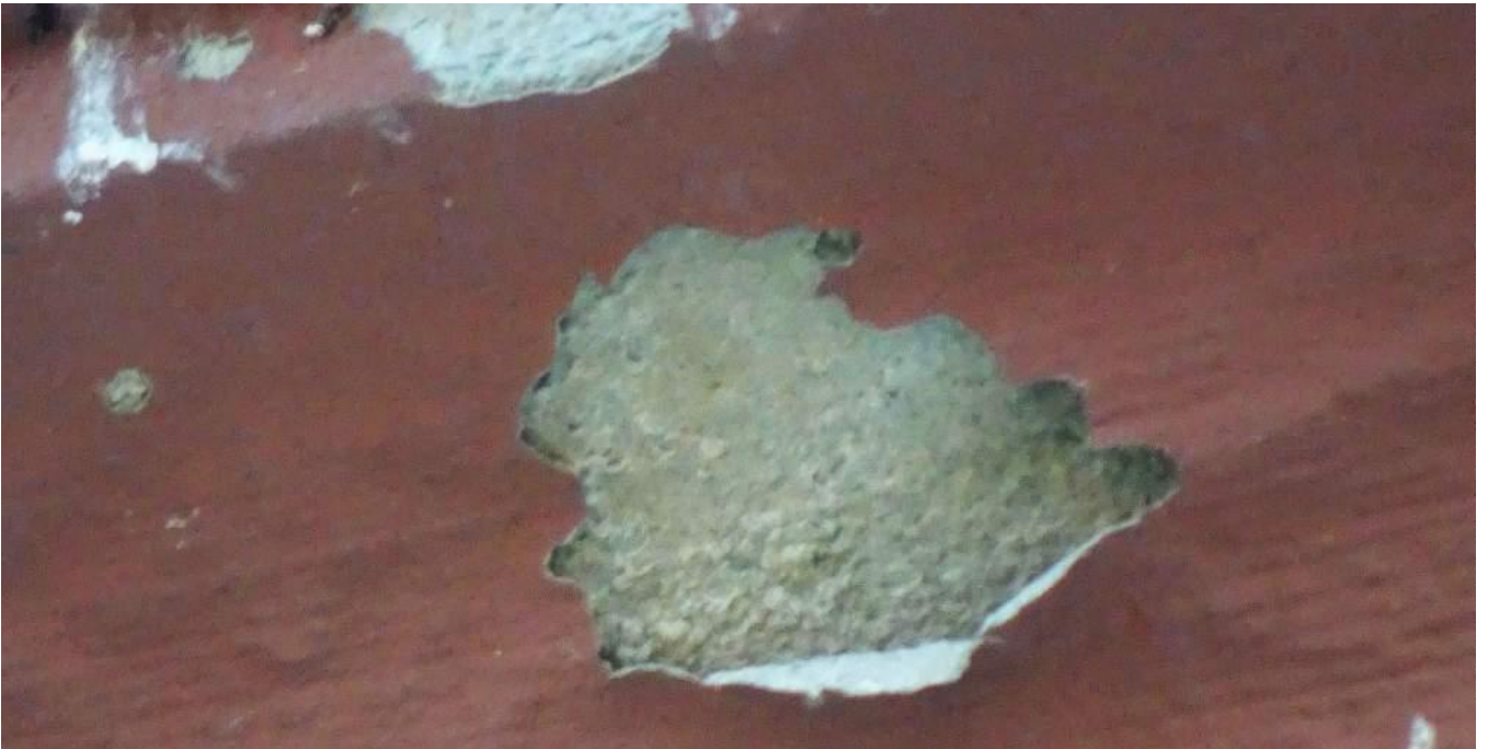
Oktober 2018 Dachrand, Blick nach S:
